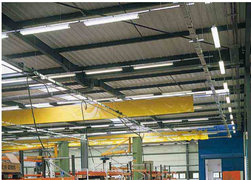
Canalis KN 40...160 A, >> für Transport und Verteilung kleiner elektrischer Leistungen.
