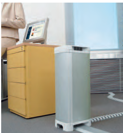
Das Brüstungskanalsystem stellt an der Wand vielfältige und umfangreiche Basisinformationen zur Verfügung. Zusätzlich passt sich der Raumverteiler als Teil des Raumverteilungssystems an die Position der einzelnen Arbeitsplätze an.
